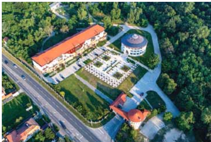
A Iosephinum területén, északon a kép sarkán az Energiaépület
